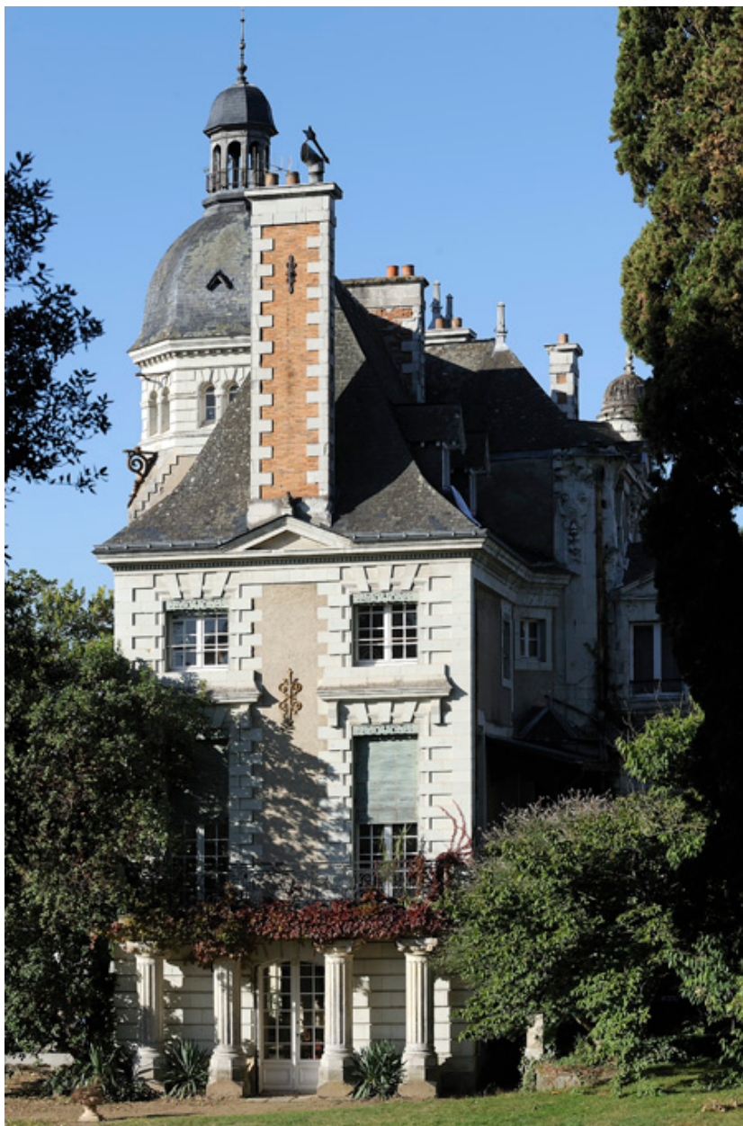
Façade du château et sa grande cheminée en briques.
