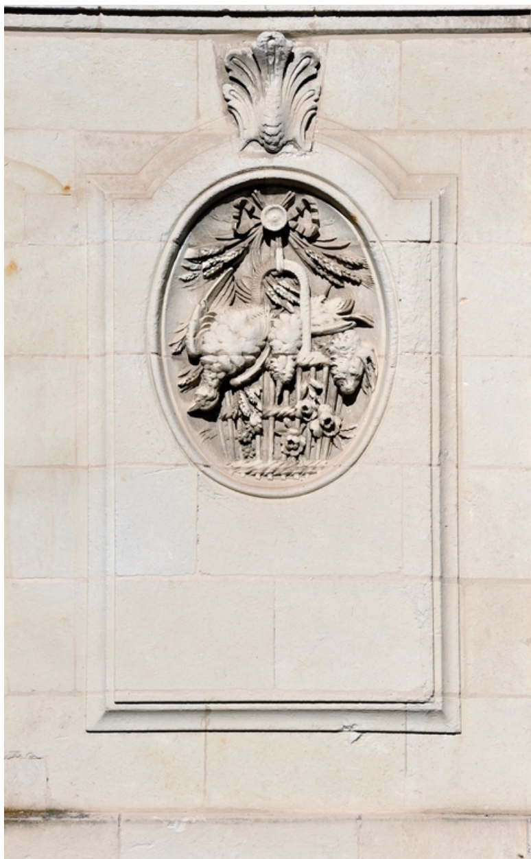
Détail de l'une des tables sculptées d'un médaillon sur la façade orientale.
