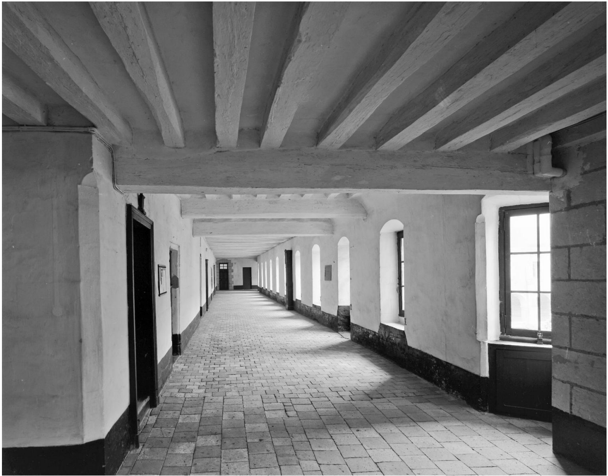
Aile sud du cloître, premier étage : couloir et portes des cellules vus depuis l'ouest.
