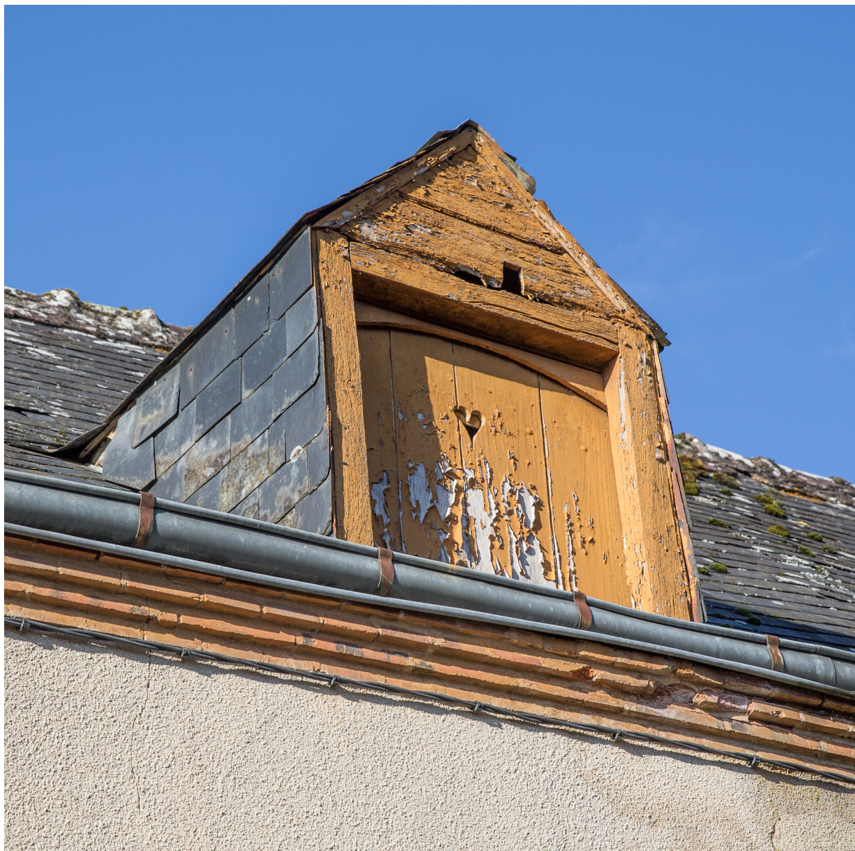
Un détail d'une lucarne, rue des Sabotiers.
