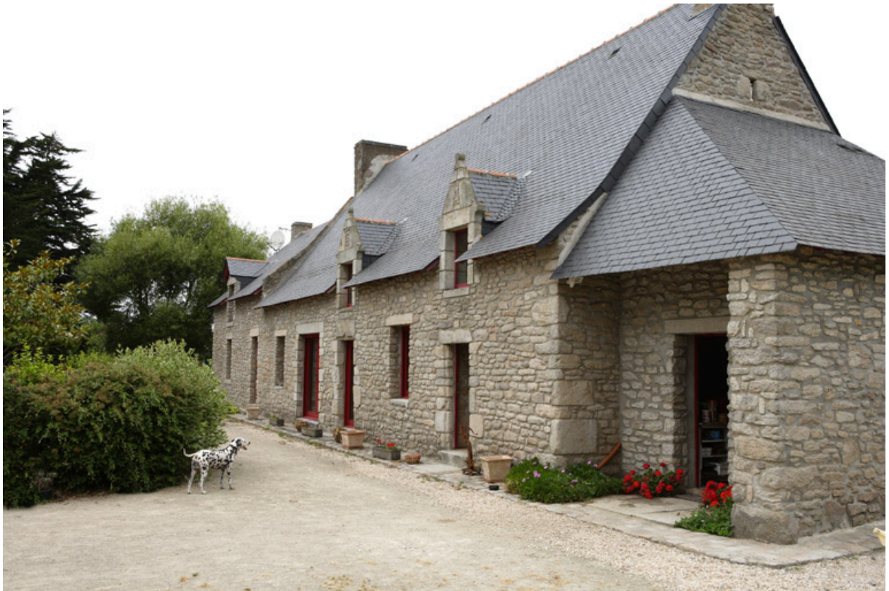
Logis. Vue de la façade sud, depuis l'est.
