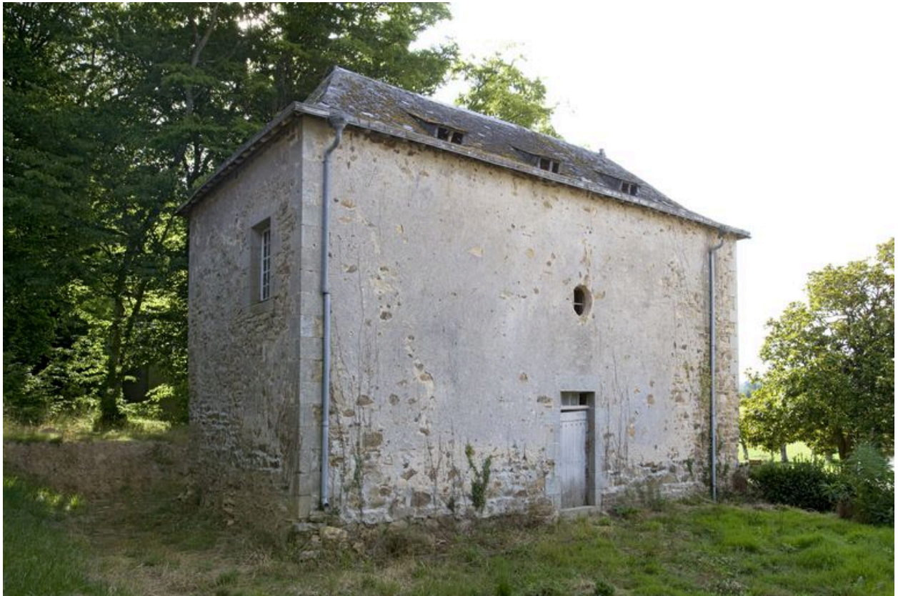
Le fruitier : façade principale vue de trois-quarts depuis le nord-ouest.
