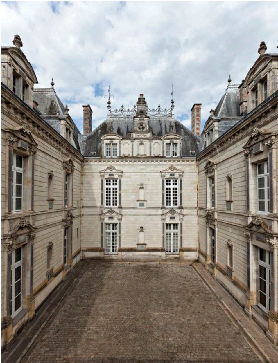
Aile du XVIIIe siècle : façade sur cour.
