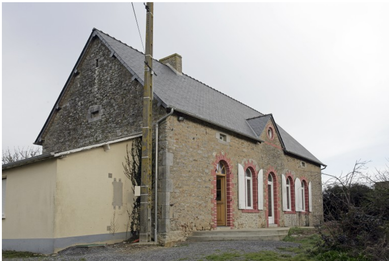
Le logis vu depuis le sud-est.
