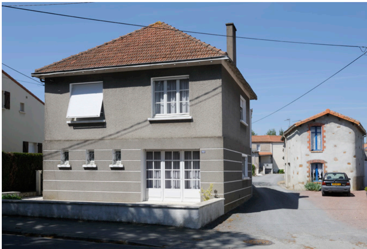
Maison de l'industriel René Chauvière, située au 48 rue de Bretagne.
