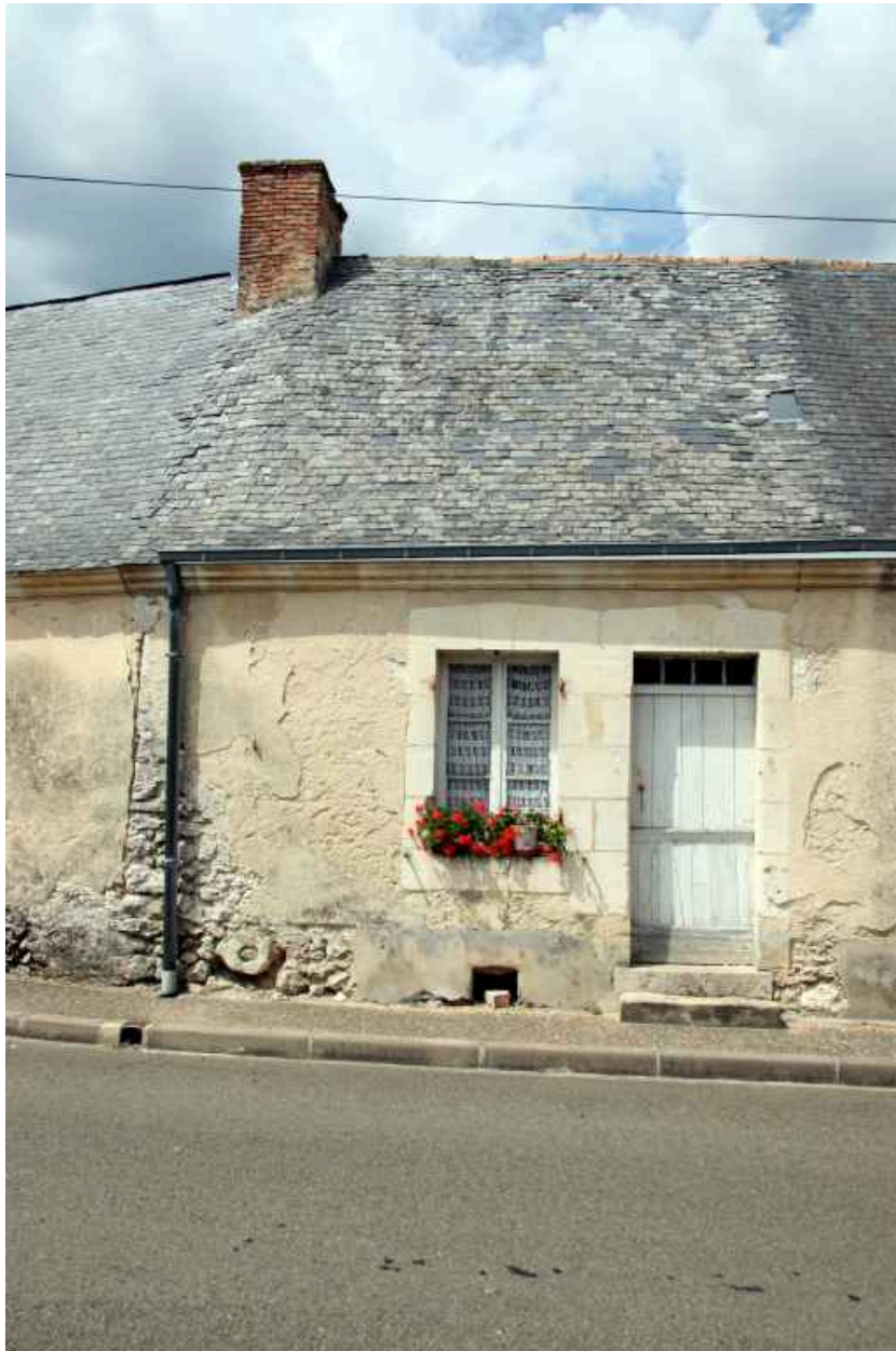
Rue des Pensées, rive ouest : autre logement.
