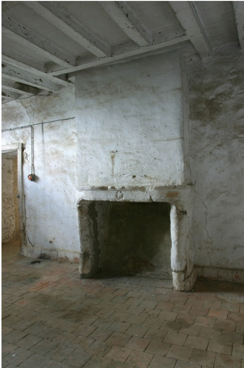
Rez-de-chaussée surélevé. Pièce 3B. La cheminée, située contre le mur sud.
