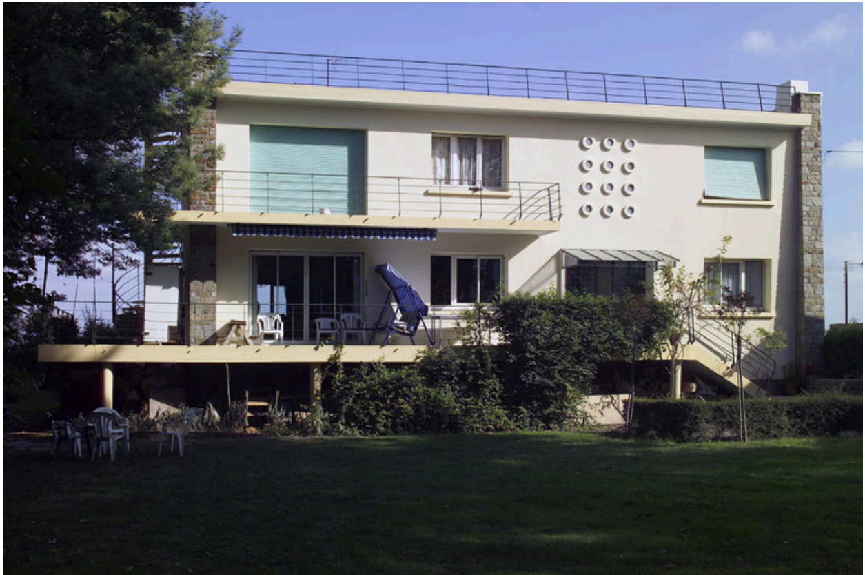
Vue de la façade antérieure de la maison depuis le jardin.
