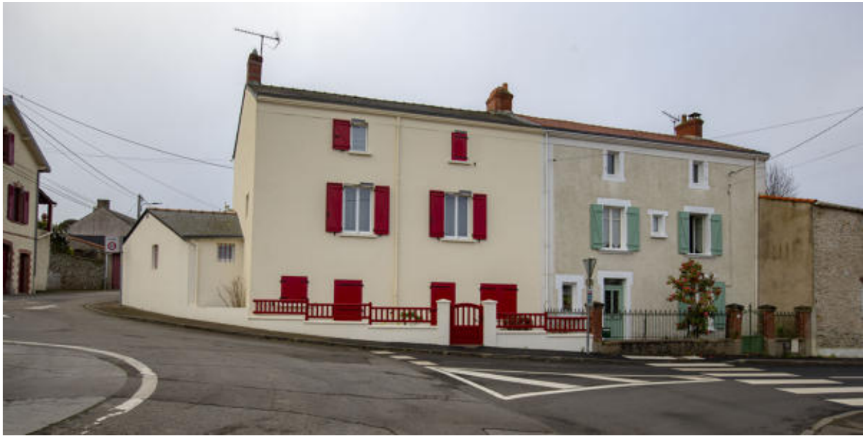
Ensemble de deux maisons, rue du Bac.
