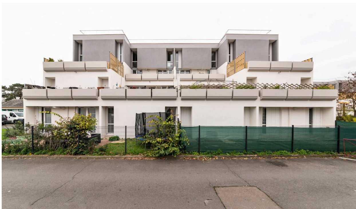
Vue de la façade principale d'un immeuble.
