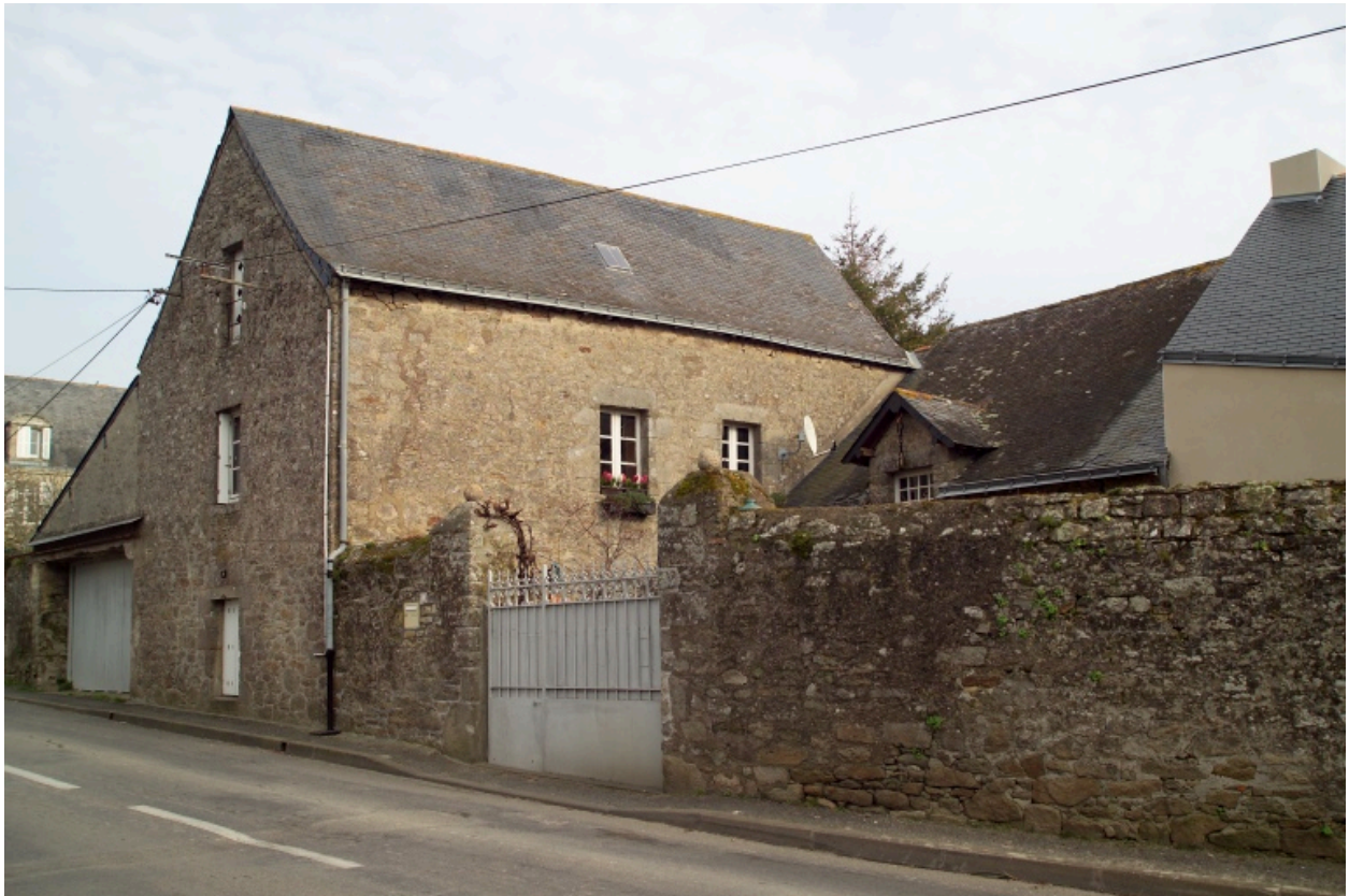
Ancienne maison de l'exploitation agricole.
