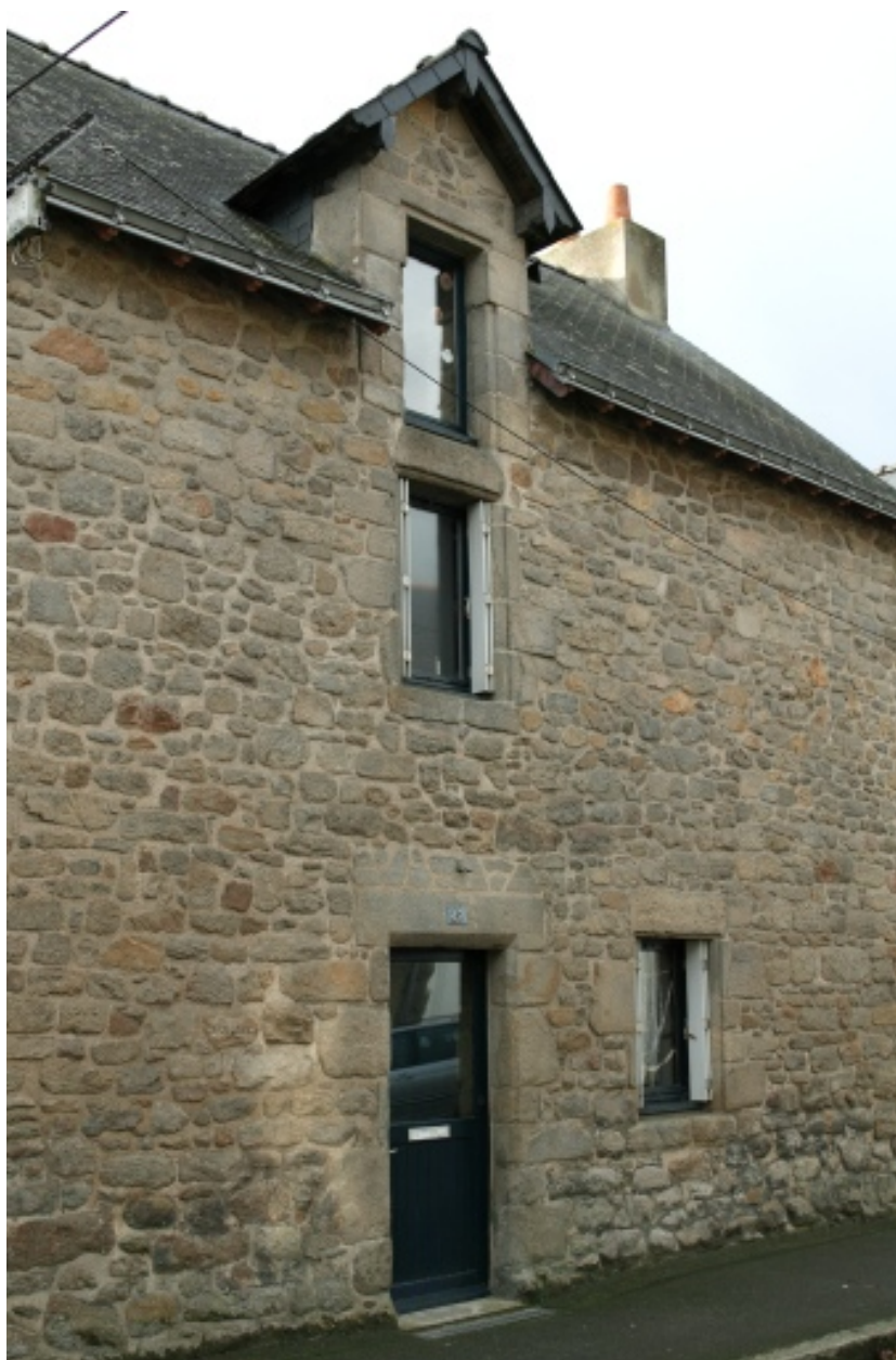
Façade sur rue, détail de la travée d'ouvertures.
