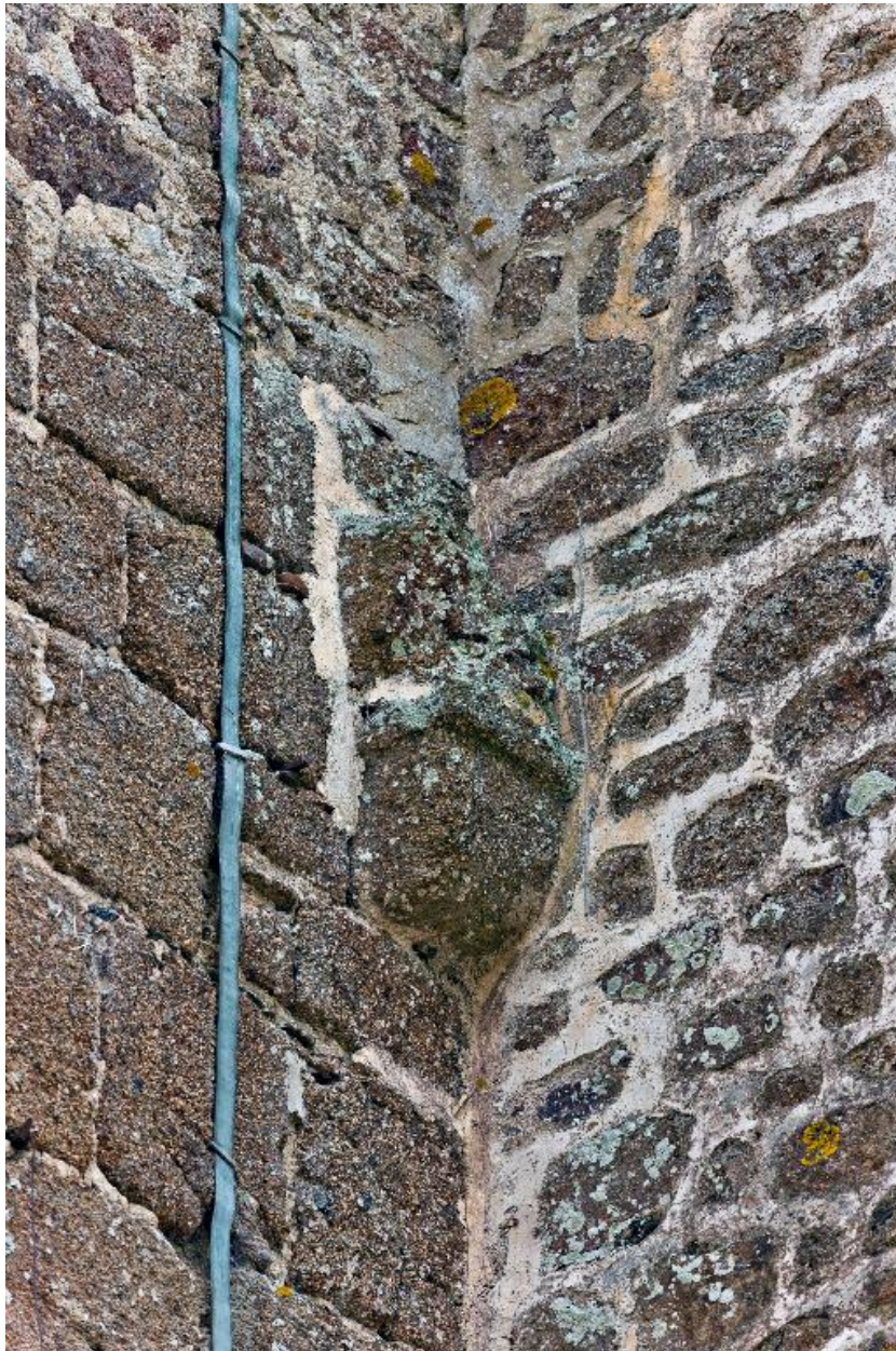
Vue de détail de l'élévation postérieure : corbeau situé au premier étage du corps principal, à la jonction avec la tour sud.
