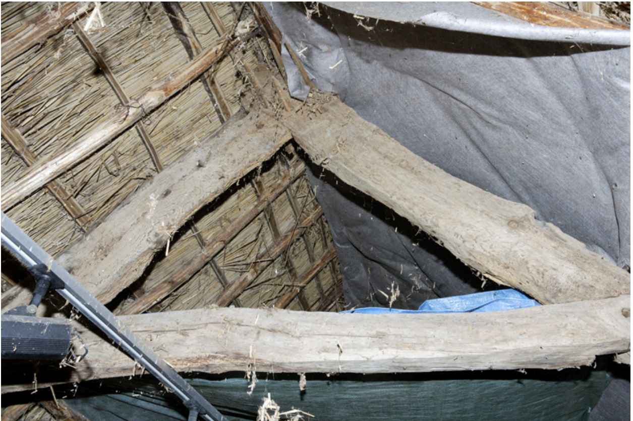
Étable sud. Détail d'un l'assemblage à mi-bois de la charpente.
