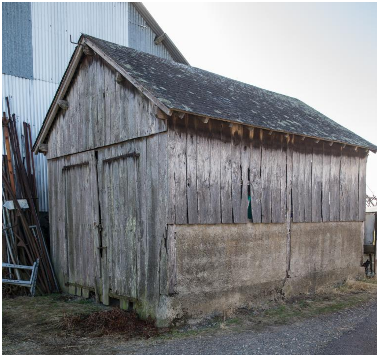
Ferme 2, remise agricole en planches de bois.
