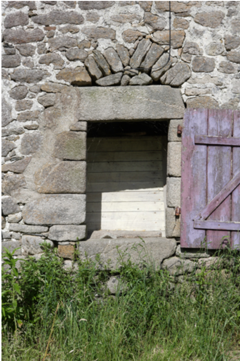
Dépendances. Façade est. Détail de la baie droite du rez-de-chaussée.
