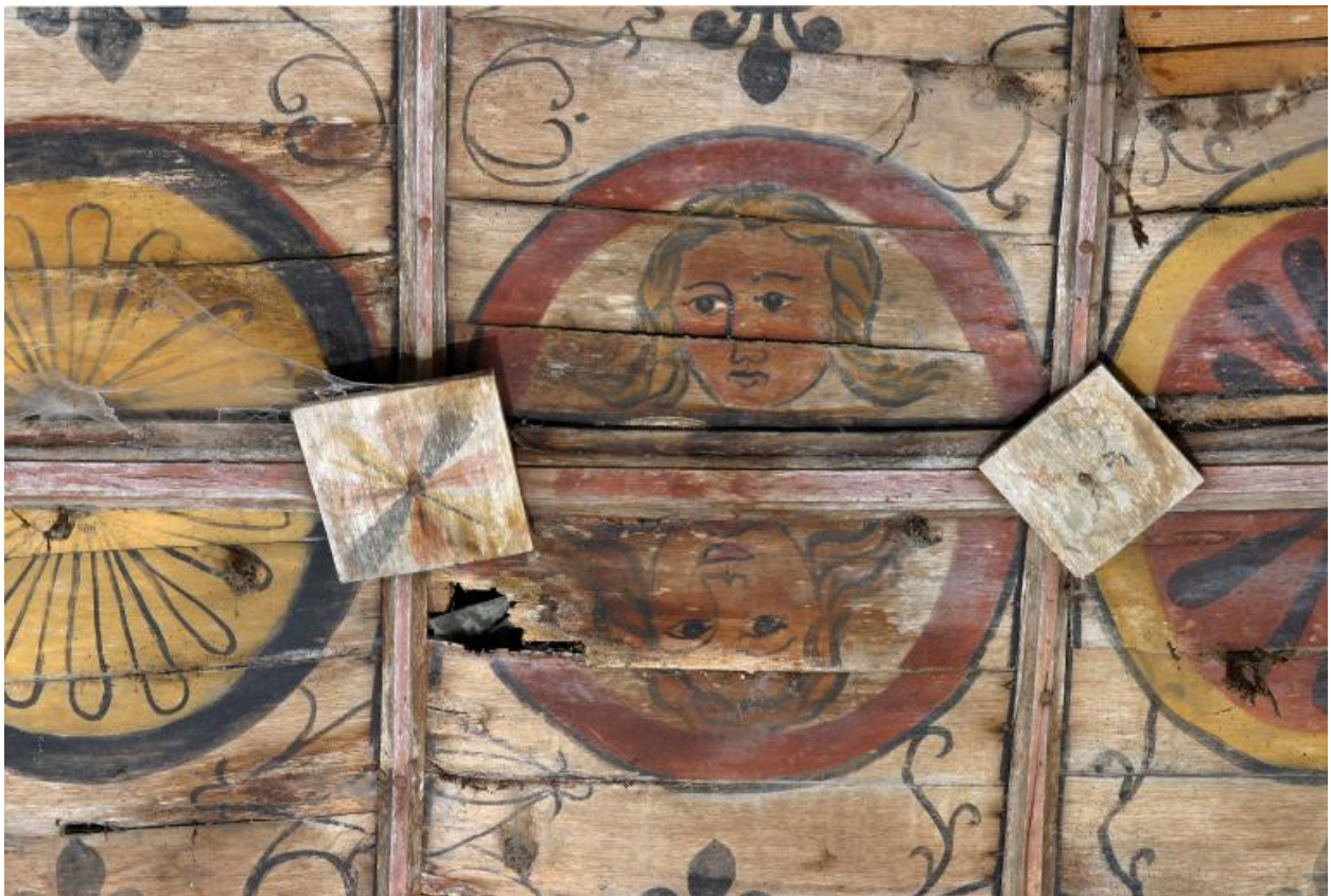
Nef, voûte, côté sud, première travée, registre de faîte : deux visages de face.
