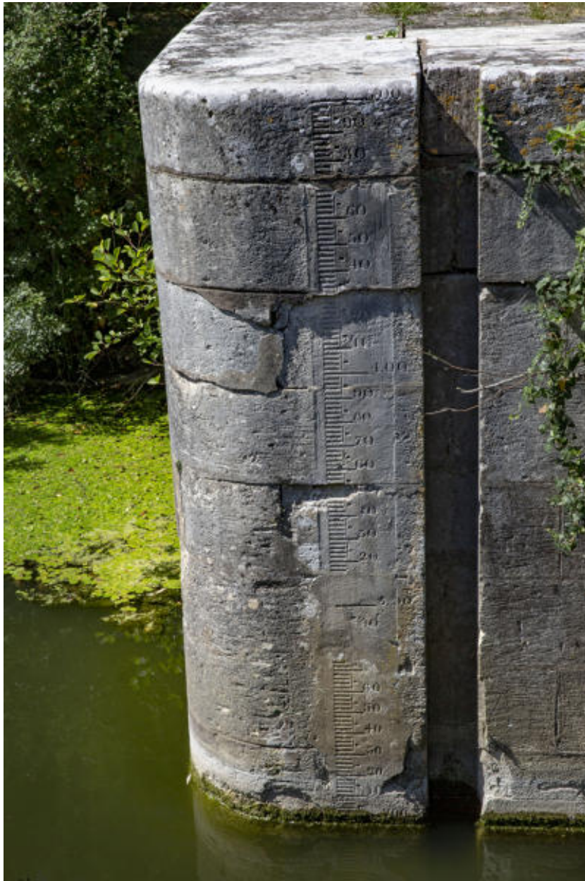
Echelle graduée pour mesurer le niveau d'eau, à la tête aval de l'écluse, rive droite.
