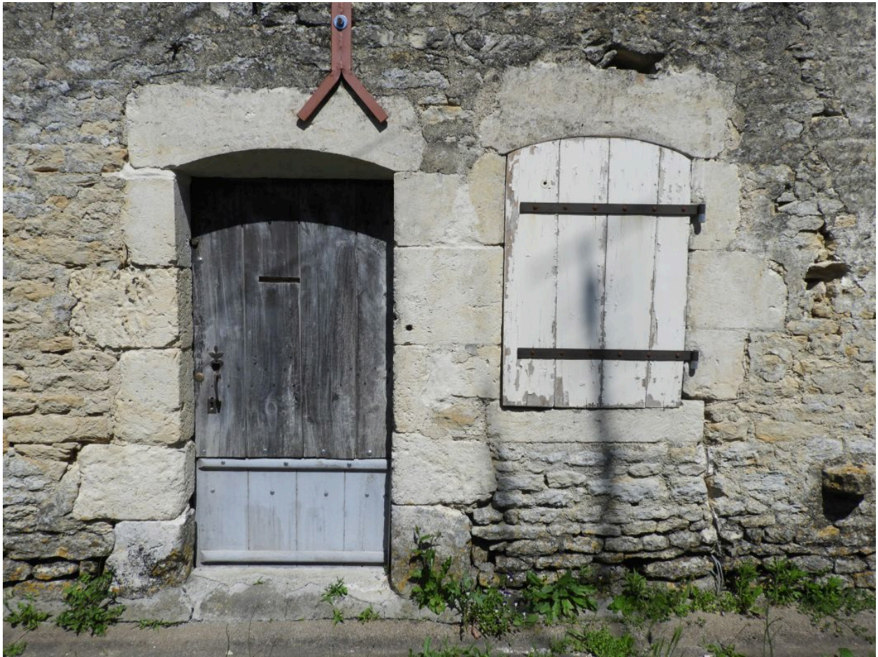
Ouvertures du 18e siècle au rez-de-chaussée de la maison.
