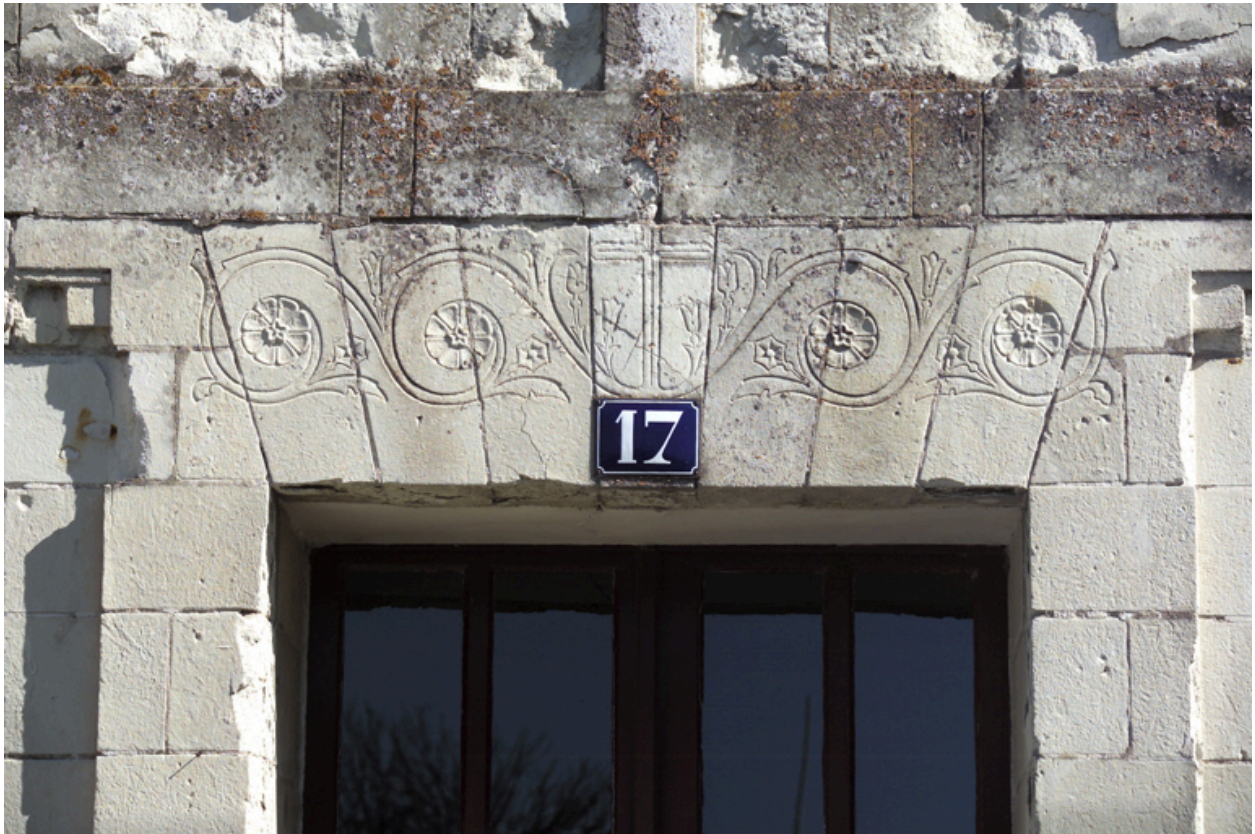
La façade antérieure, détail du linteau de la porte d'entrée.
