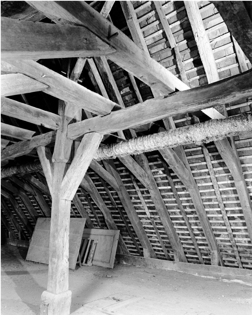
Aile nord du cloître (aile du chapitre), 2e niveau du comble : détail sur une ferme de la charpente.
