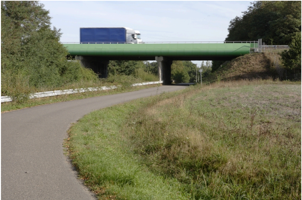
Pont en béton pré-contraint.
