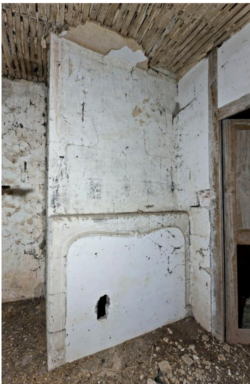
Dépendance 1, comble : cheminée.
