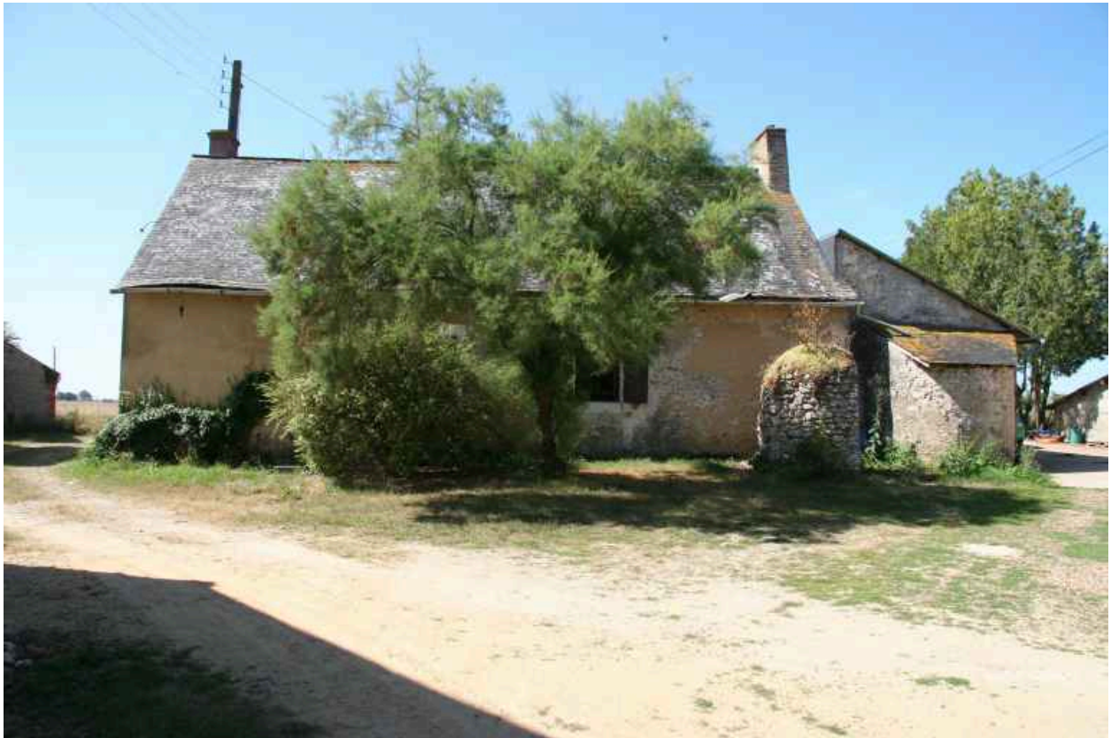
Maison n°2 : façade postérieure.
