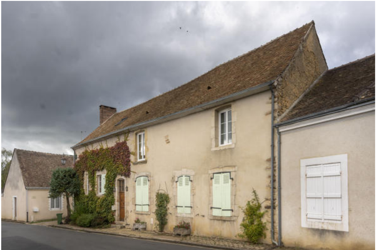
Façade principale du 18 rue Notre-Dame composée des trois maisons.
