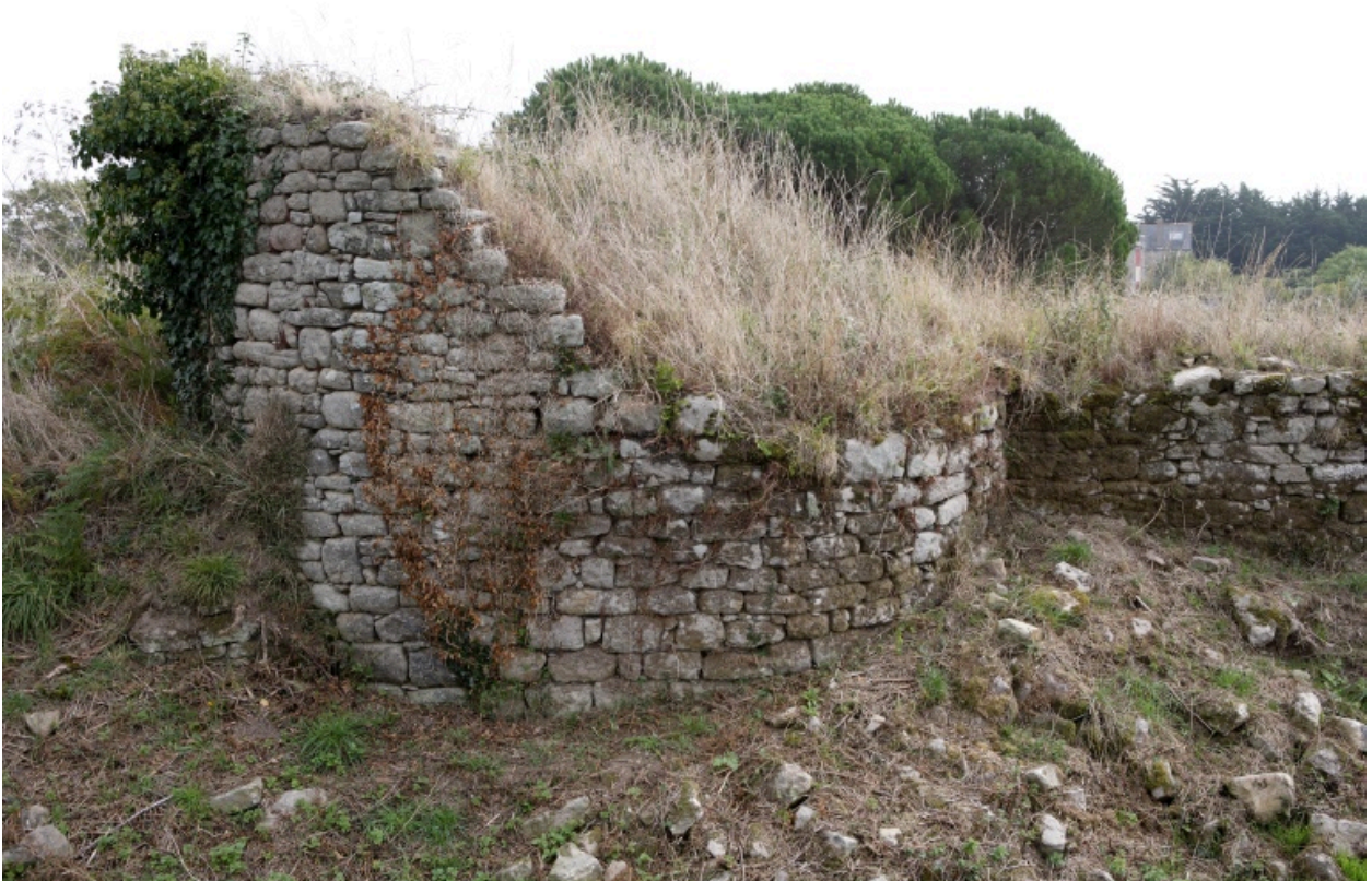
Détail de la tourelle dans l'angle nord-ouest du mur de clôture.
