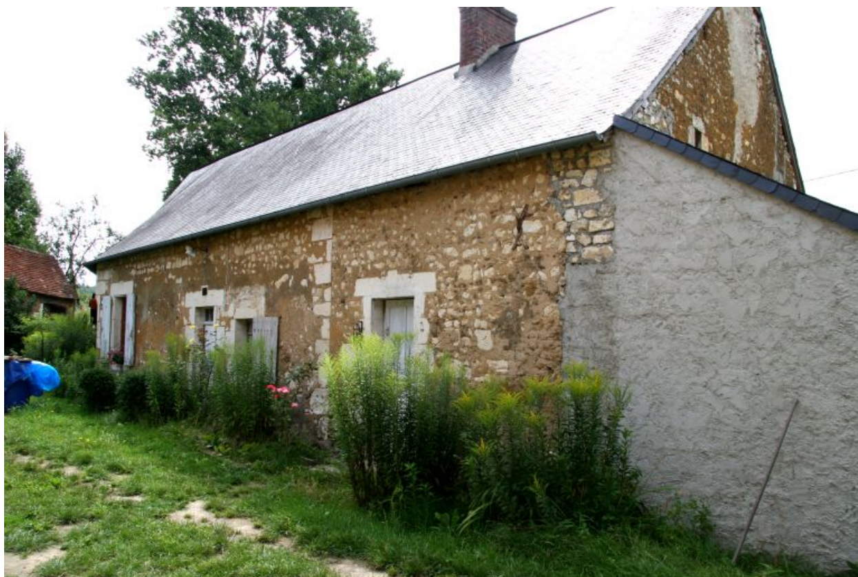
Le moulin : façade antérieure sur cour.
