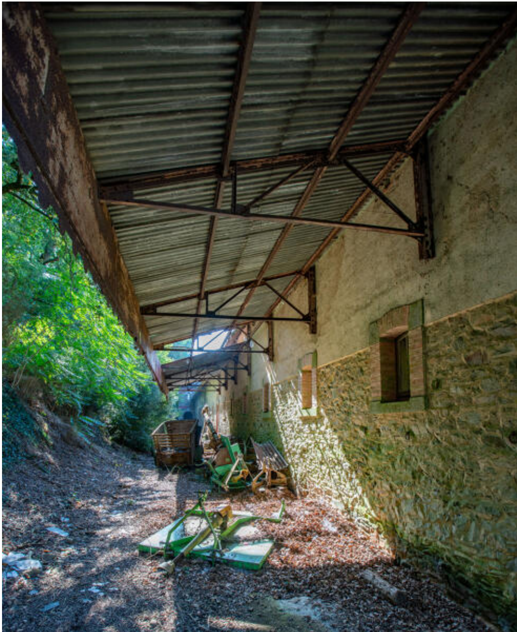
La marquise et la façade postérieure des communs.
