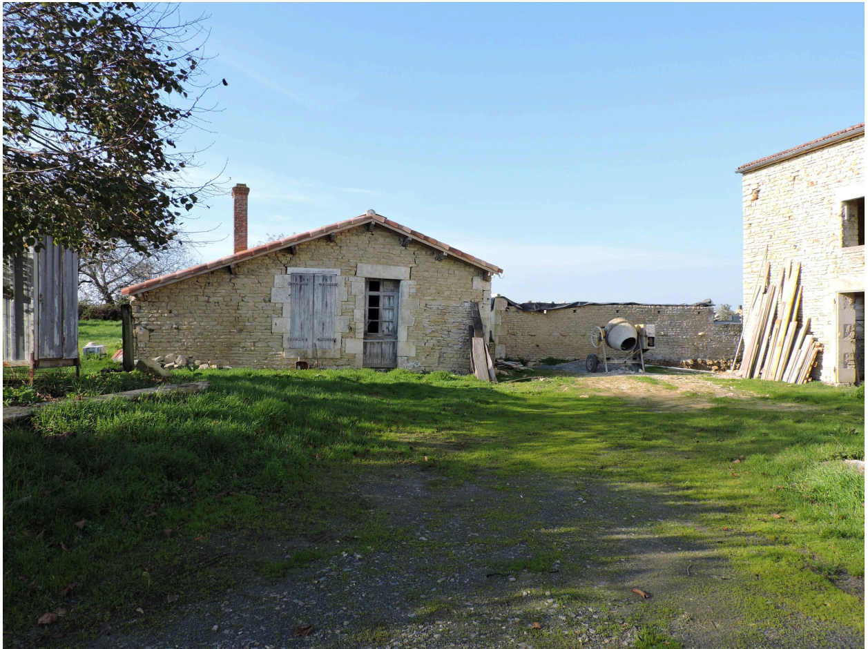
La buanderie vue depuis l'est.
