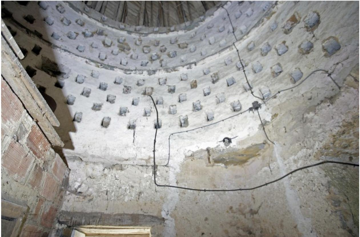
Vue intérieure du colombier : le ressaut indiquant l'emplacement d'un ancien plancher.
