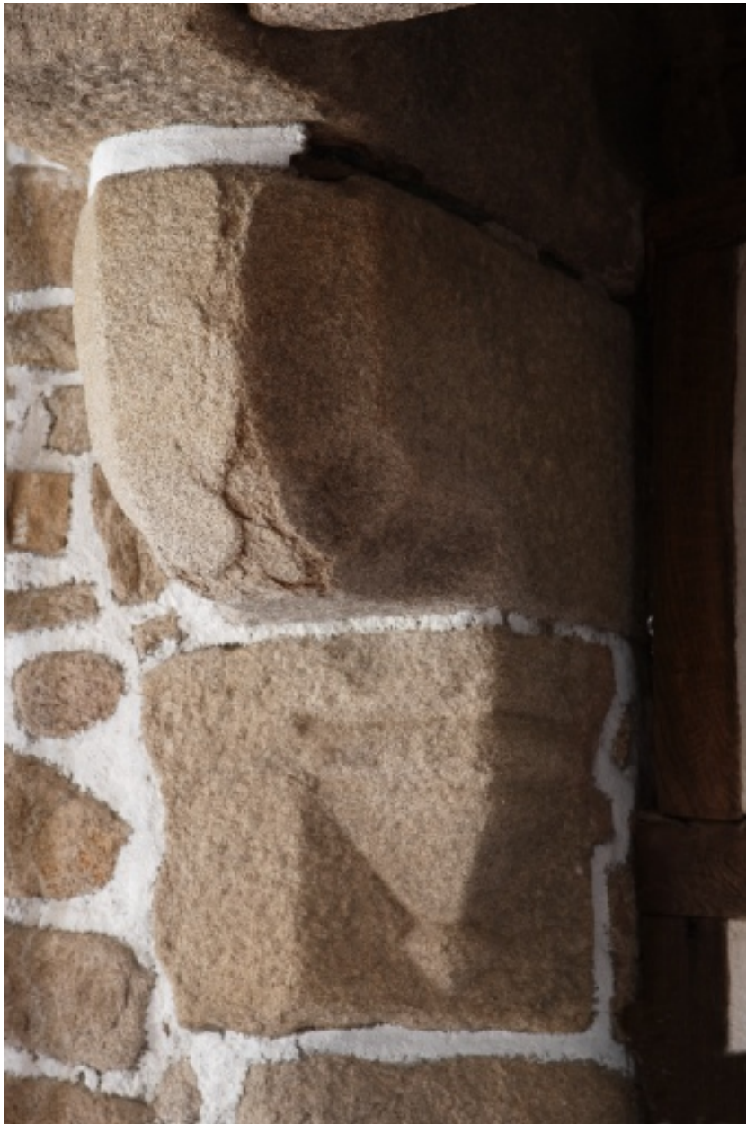
Détail de la console de gauche de la cheminée ouest.
