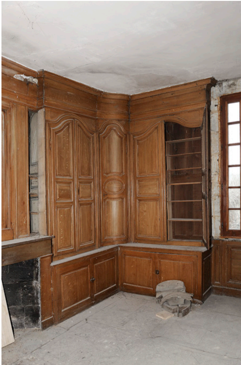
Etage, salle lambrissée, angle sud-ouest (2).
