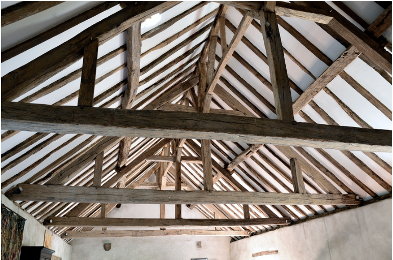
Chai. Détail de la charpente.
