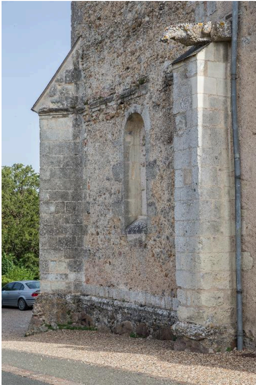
Tour-clocher, mur sud, niveau rez-de-chaussée.
