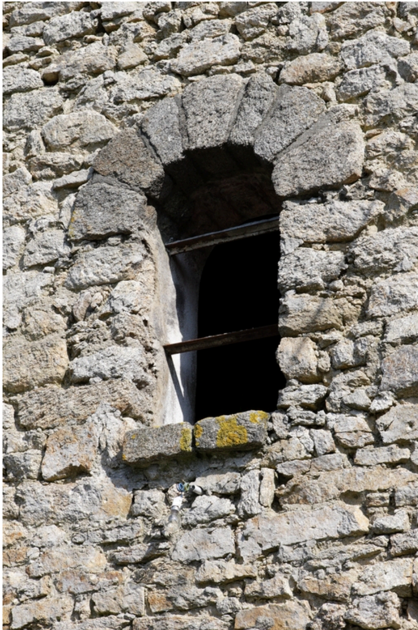
Détail du jour situé sur le pignon sud de l'étable.
