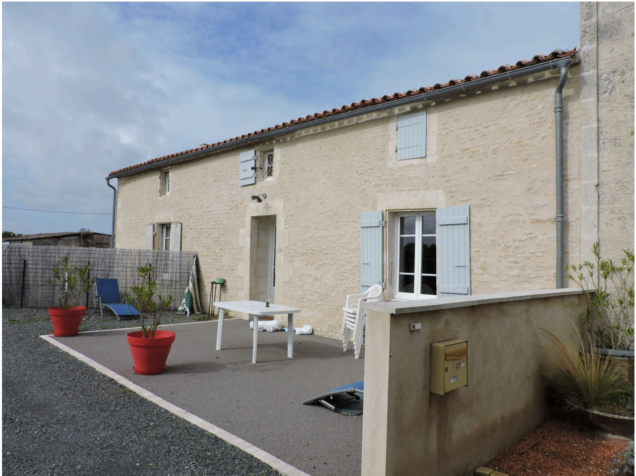
Le logis vu depuis le sud-est.
