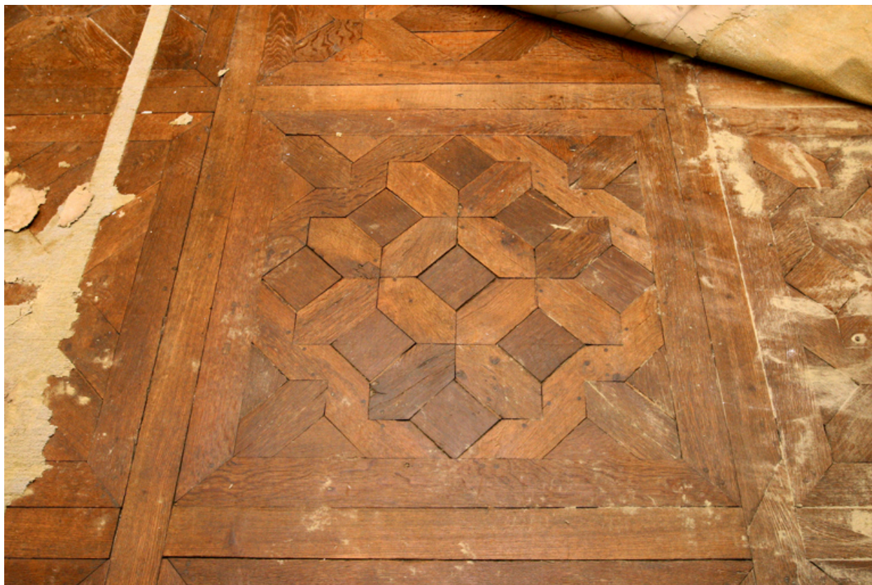
Détail du parquet à l'étage de l'aile sud, salle centrale.
