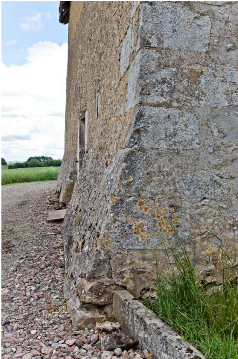
Détail de l'angle antérieur gauche de la grange-étable-fenil
