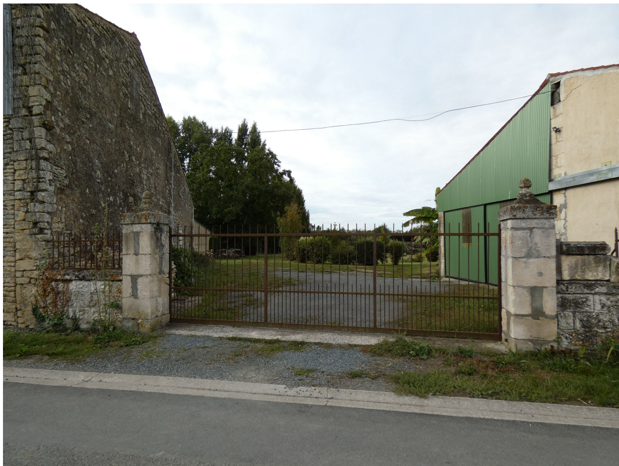
Le portail vu depuis le nord.
