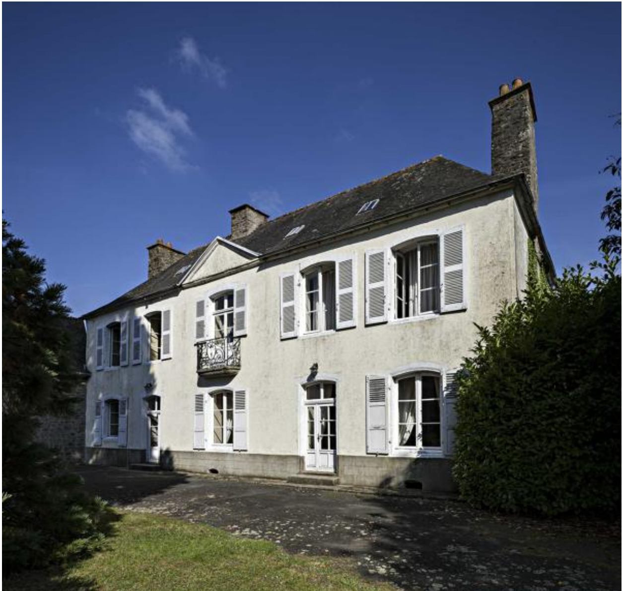
Maison de maître de la Touche, vue de la façade.
