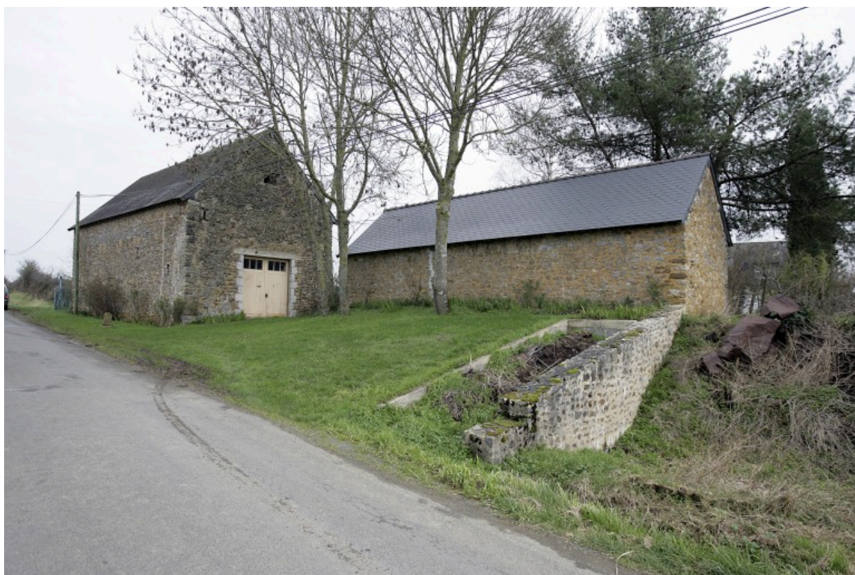
L'étable et la remise vues depuis la route au sud-ouest.
