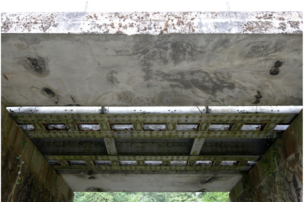
Tablier : accotements, poutres et entretoises, vue inférieure.
