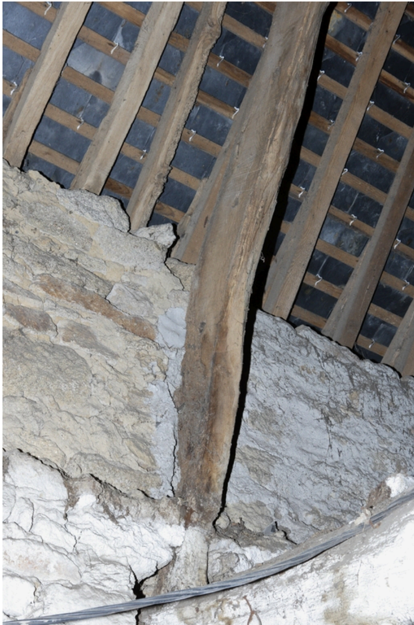
Bâtiment ouest. Détail de l'insertion d'un arbalétrier dans la maçonnerie.
