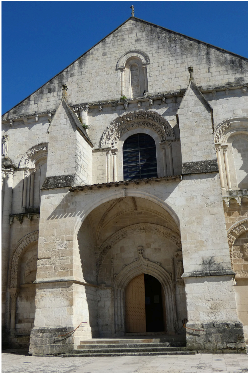
Le portail gothique et ses contreforts accolés à la façade occidentale.
