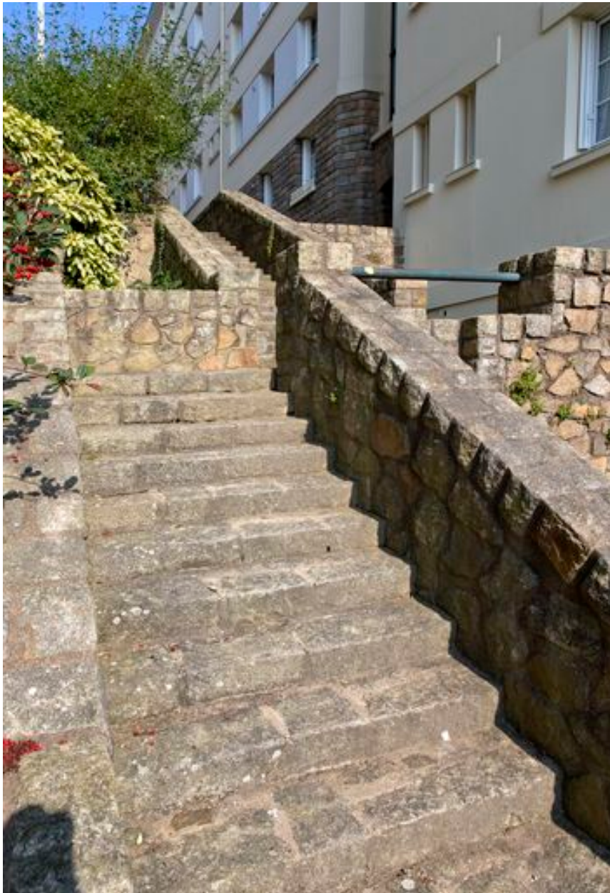
Escalier situé entre les bâtiments D et E.
