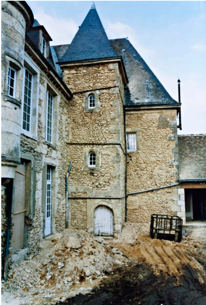
Logis, tour d'escalier : état pendant la restauration de 2008
